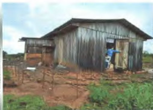
Foto Frontal da Residência
