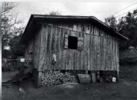
Foto Frontal da Residência
