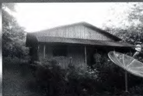
Foto Frontal da Residência
