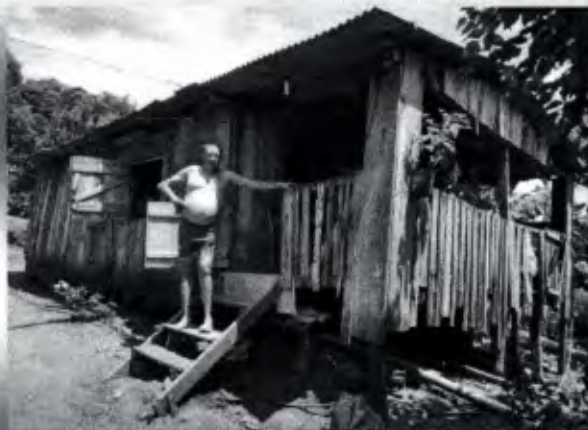
Foto Frontal da Residência
