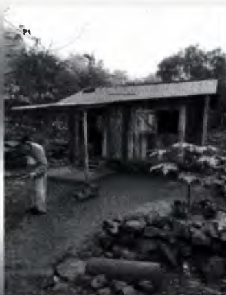
Foto Frontal da Residência
