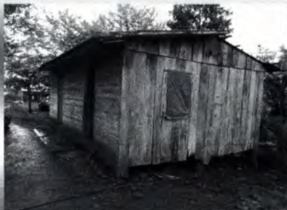
Foto Frontal da Residência
