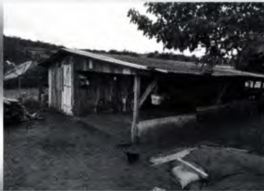
Foto Frontal da Residência
