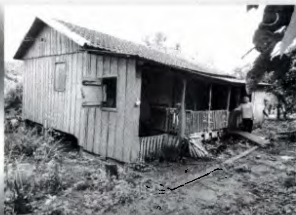
Foto Frontal da Residência
