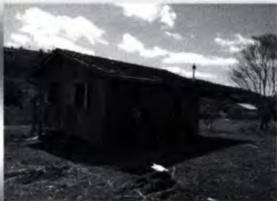
Foto Frontal da Residência
