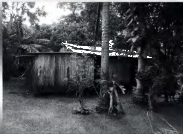
Foto Frontal da Residência
