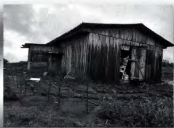
Foto Frontal da Residência
