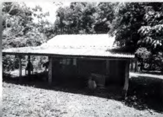
Foto Frontal da Residência
