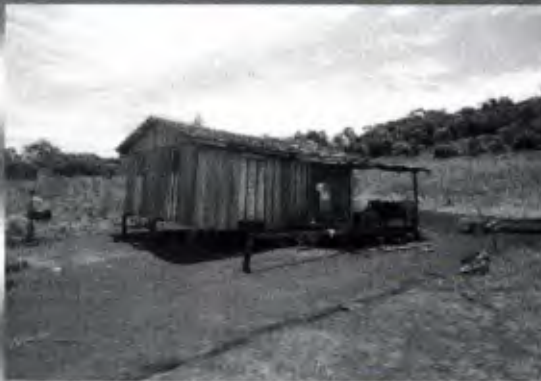
Foto Frontal da Residência
